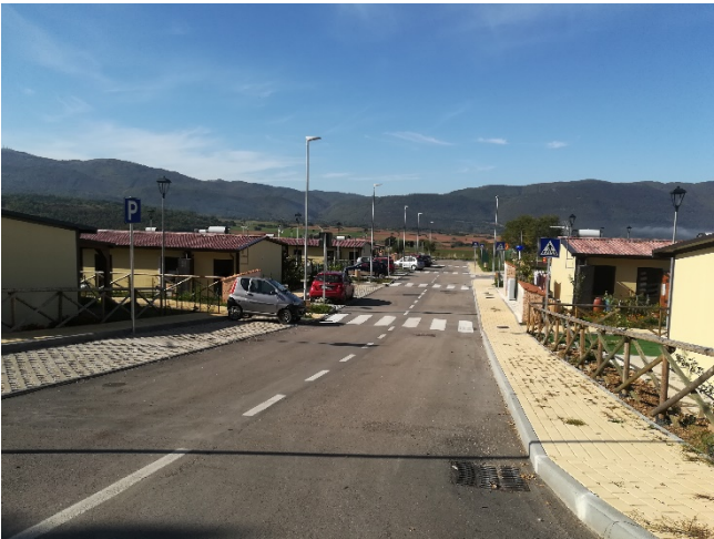
Norcia – San Pellegrino (2019) – Disposizione delle SAE (Soluzioni abitative d'emergenza)
